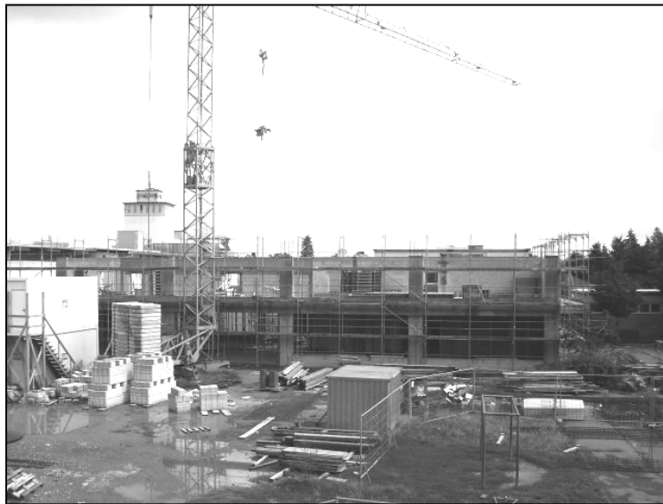
Anbau an die Karl-Wendel-Schule (für die Ganztagschule) im Bau
