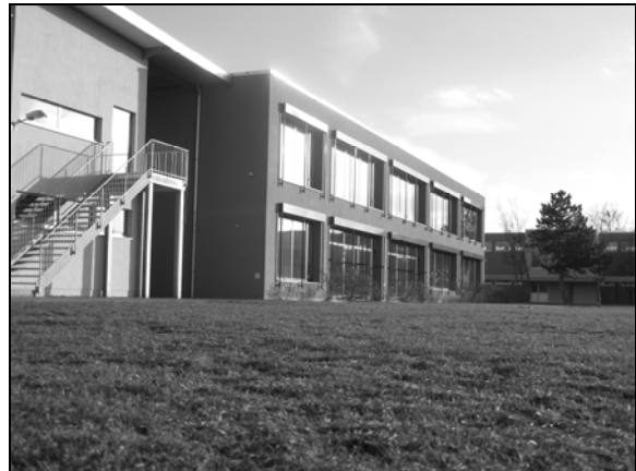
Westansicht der Karl-Wendel-Schule – Mensa und Sporthalle
